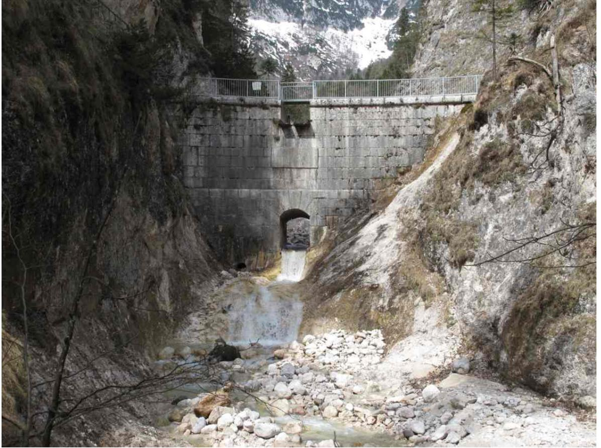
Durch die Almbachklamm wurde bis zum Jahre 1963 Holz getriftet. Zu diesem Zweck wurde von 1834 bis 1836 im oberen Teil der Klamm eine 14 m hohe, 6 m breite und 17 m lange Staumauer gebaut.
